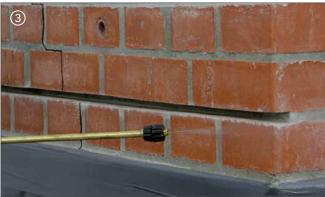
Fuge vornässen | Mouiller le joint
