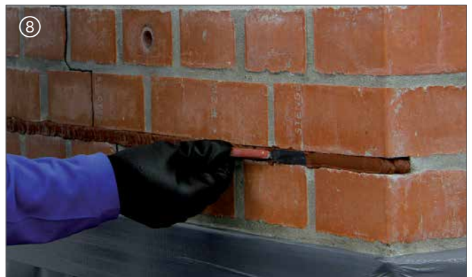
DESOI Spiralankermörtel glattstreichen | Lisser le mortier d'ancrage
