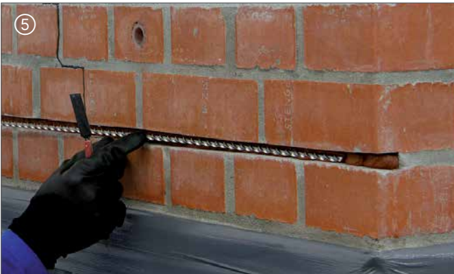
Spiralanker setzen | Placer les tirants hélicoïdaux
