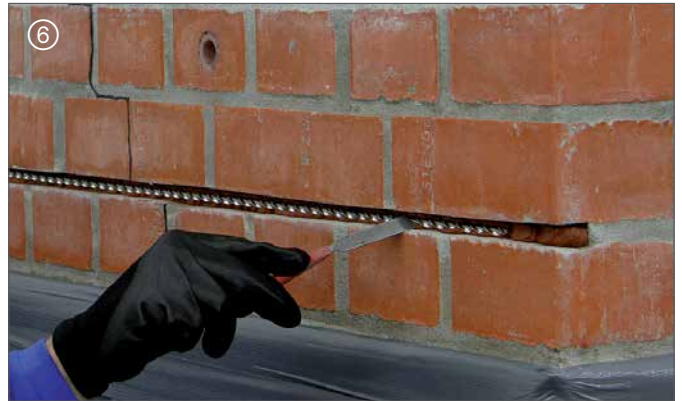
DESOI Spiralanker in den Spiralankermörtel drücken | Encastrier les tirants hélicoïdaux DESOI dans le mortier d'ancrage
