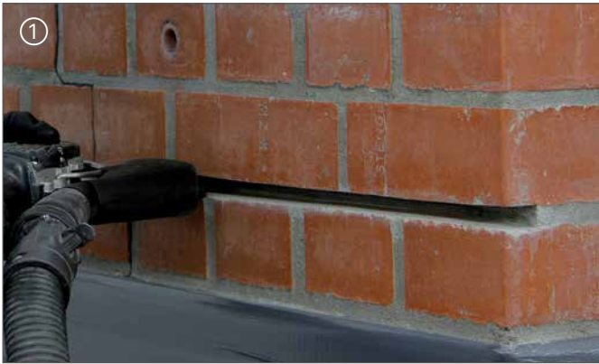
Fuge mit AS200X Stein- und Fugensäge aussägen Scrier le joint avec la Scie à brique et mortier AS200X
