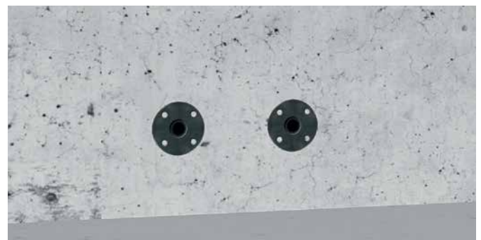
② Nagelpacker nach Entfernen der Schalung ② Injecteurs à clouer après l'enlèvement du coffrage
