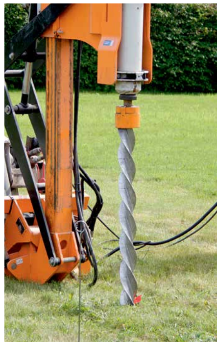
Einrammen der Gewindepfähle Enfoncer les pieux
